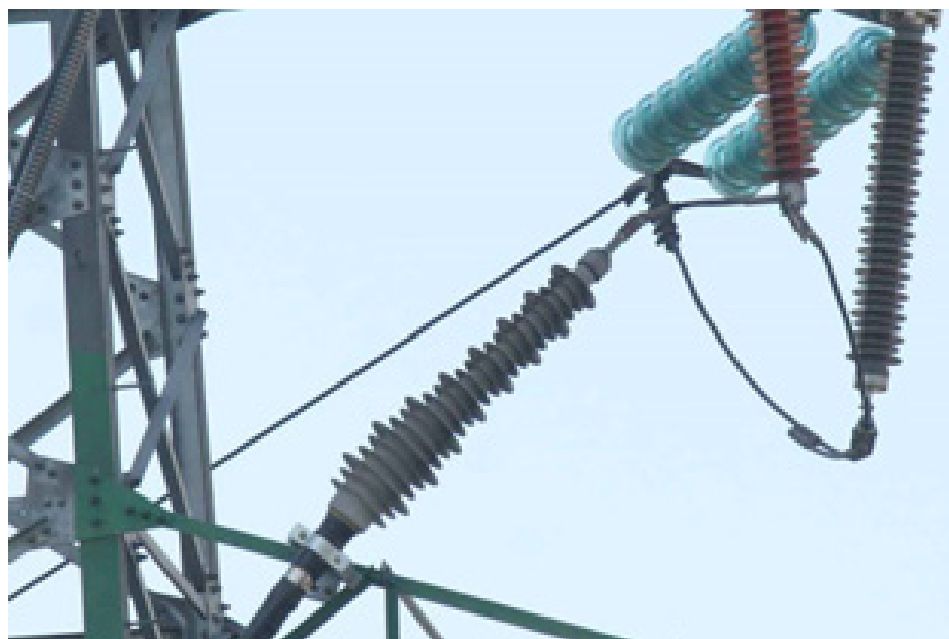
Установка муфты типа PAT130С под углом
